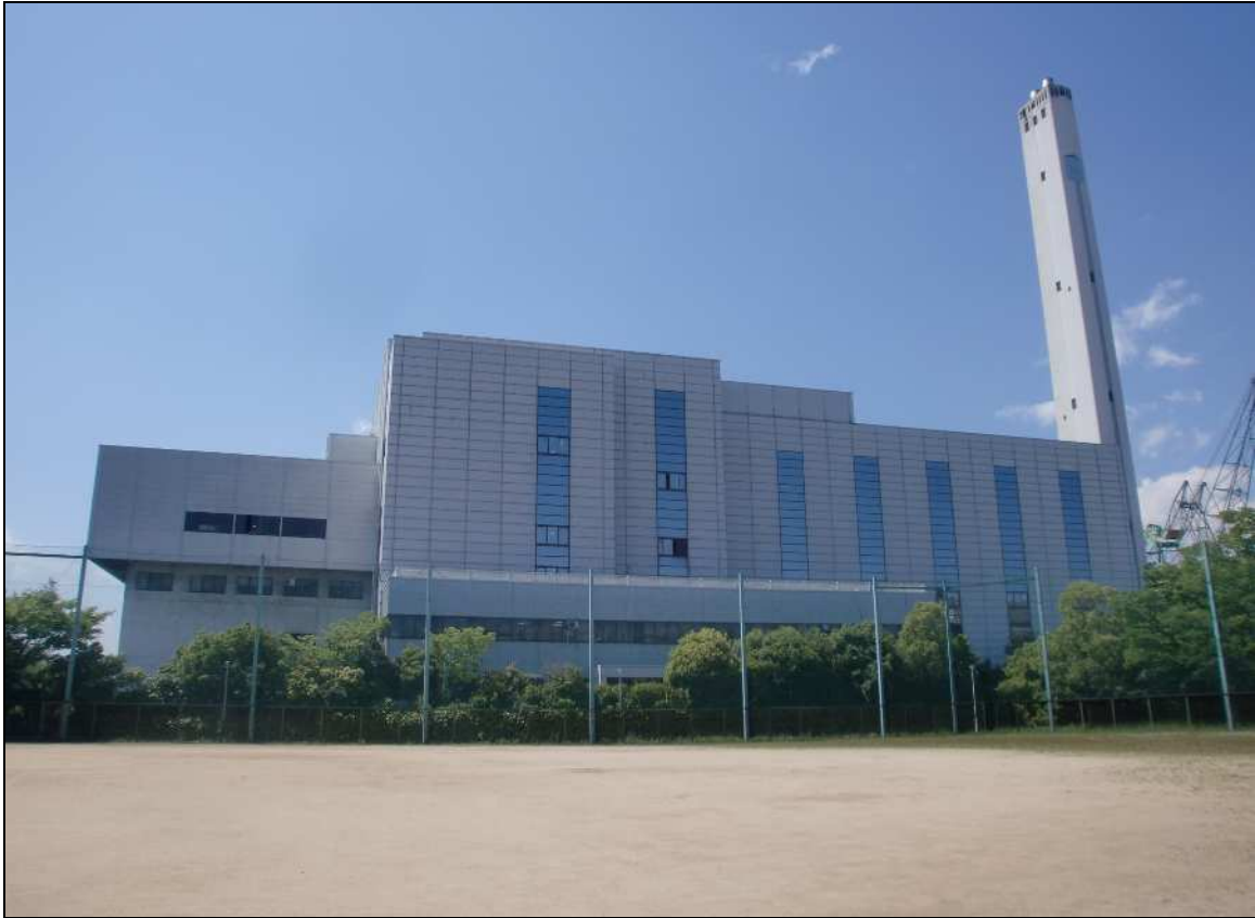
住之江工場南東側から
