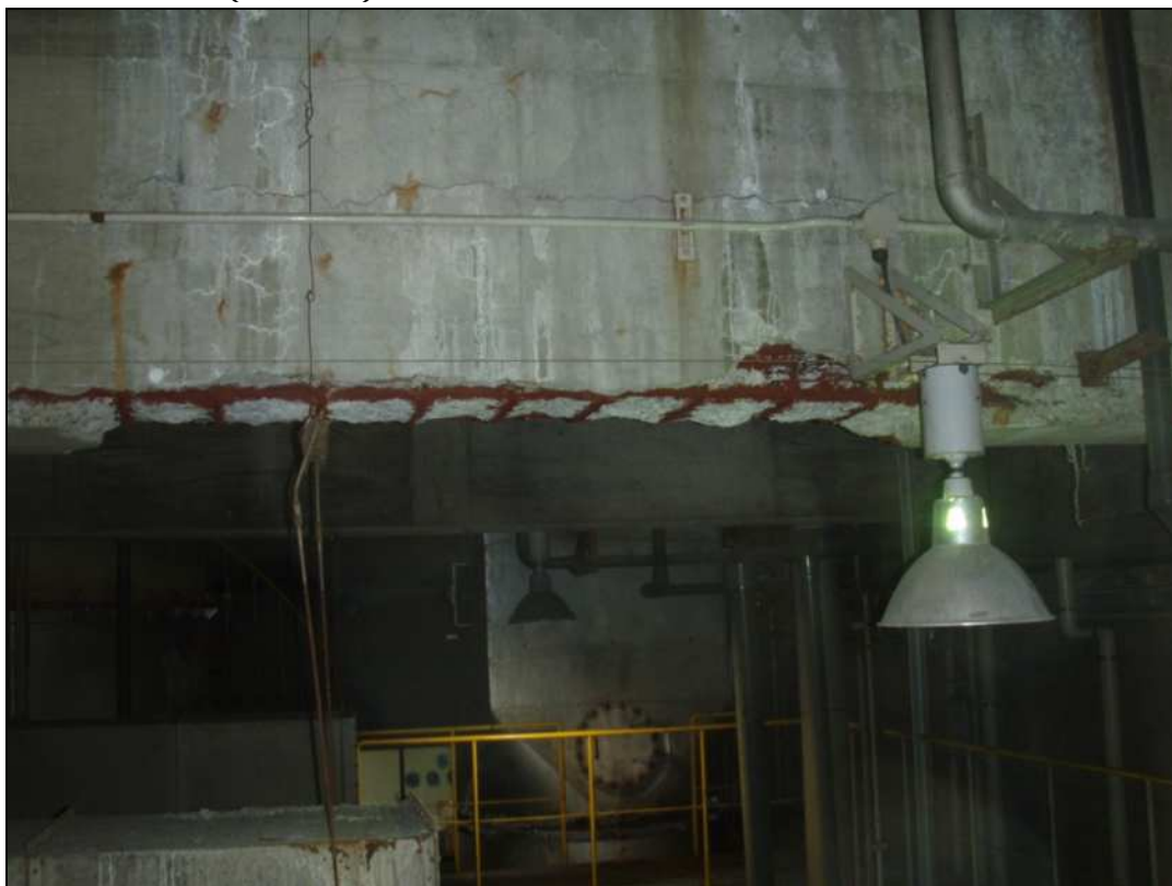
3階部分の梁（横から）
