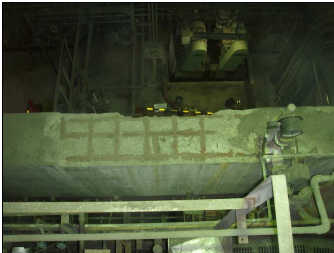
2階部分の梁（上から）
