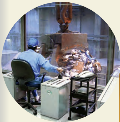
③ごみクレーン操作室 ごみクレーンを操作します。 The waste crane is operated from the crane control room full automatically or manually.
