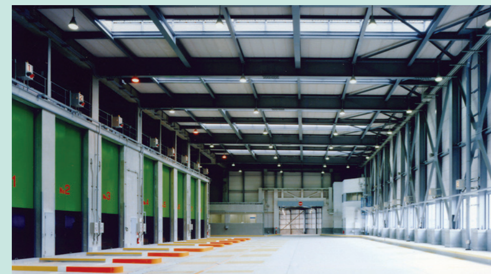
①投入扉、プラットフォーム…収集したごみは9面の投入扉からごみピットに投入されます。
