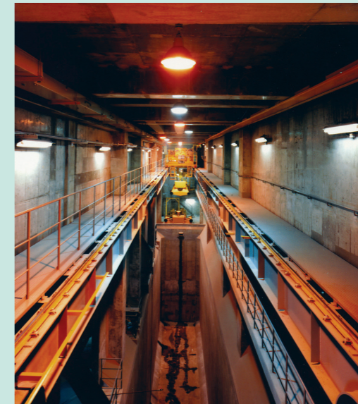
⑧灰ピット…灰はごみの約1/20の容積に、重量は1/5以下になります。
