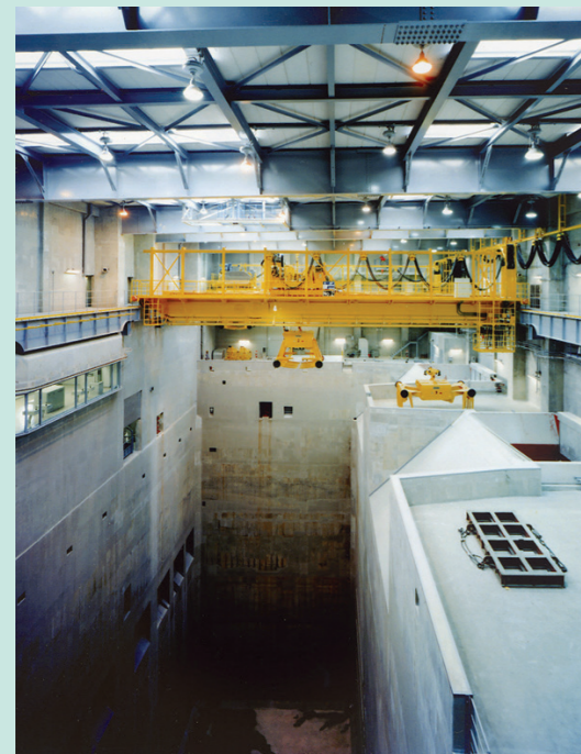
②ごみピット・④ごみクレーン…ごみピット容量約11,000m 3 、ごみクレーンつかみ量約5t(1回)。
