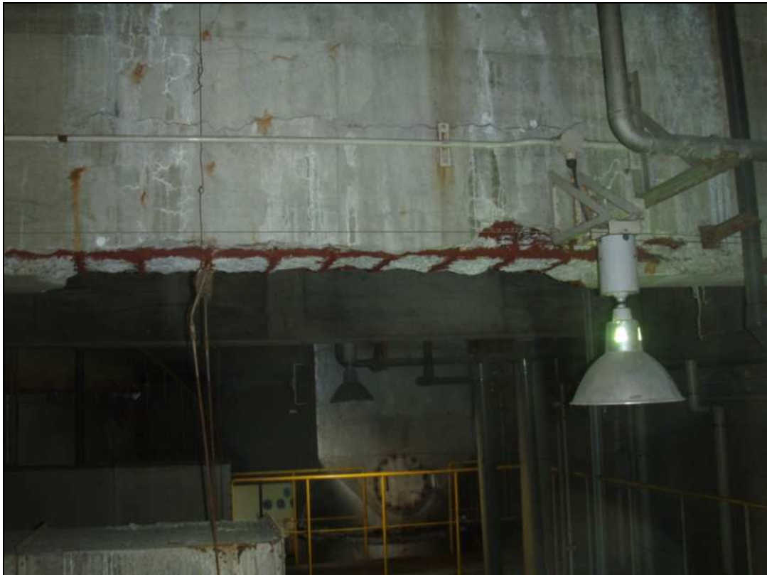
3階部分の梁（横から）
