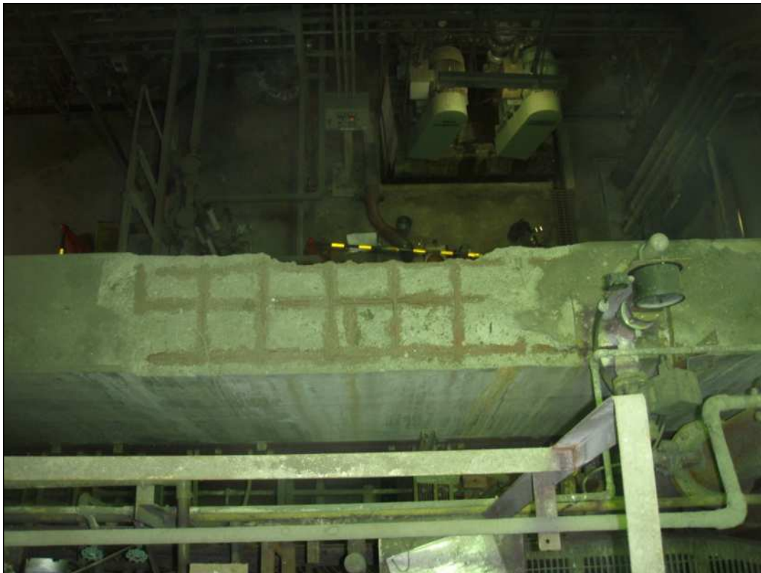
2階部分の梁（上から）
