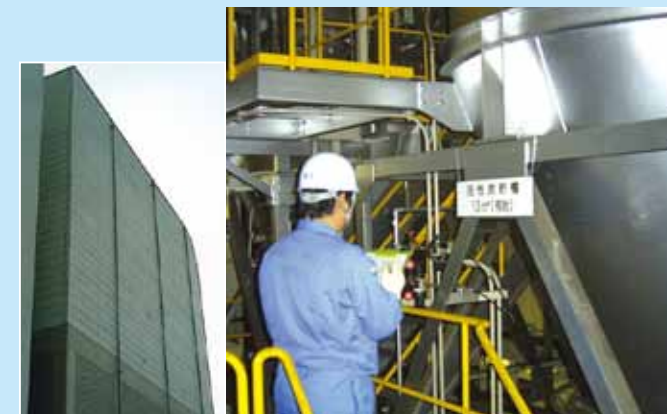
排ガス高度処理設備…排ガス中のダイオキシン類を削減します。
