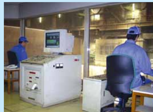
クレーン操作室…ごみクレーンを遠隔操作します。
