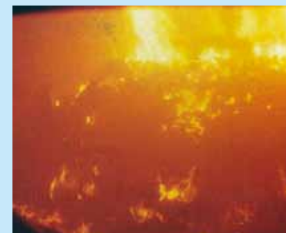
焼却炉内…約850℃～950℃の高温で焼却し悪臭は分解します。
