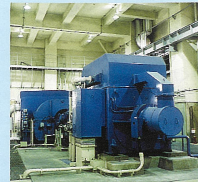
タービン・発電機…ボイラーで発生した蒸気により発電します。出力12,000kW
