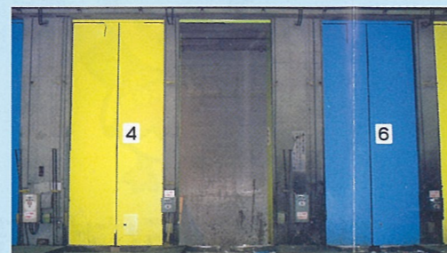
ごみ投入扉…収集したごみは9面の投入扉からごみピットに投入されます。
