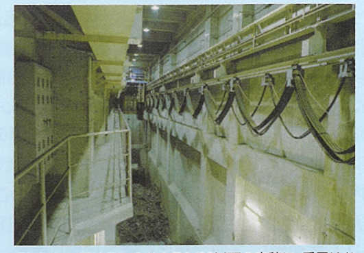
灰ピット…灰はごみのおよそ1/20以下の容積に、重量はおよそ1/5以下になります。
