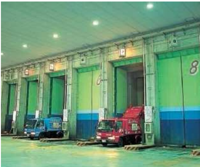
写真 - 1 プラットホーム （ごみを投入扉から貯留ピットに投入します）
