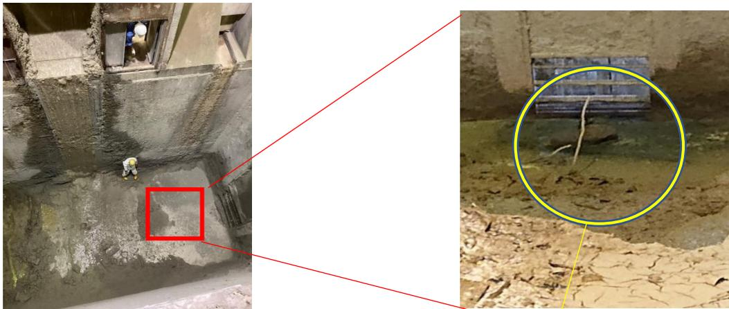
写真-1 灰ピット底部の鉄筋露出状態
