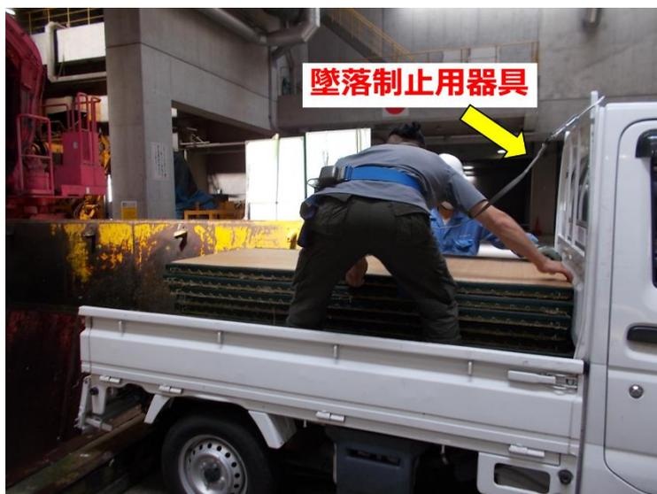
写真-16 墜落制止用器具の着用状況
