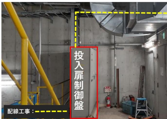
写真－6 ごみ投入扉追加配線施工箇所 2
