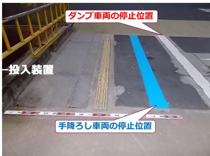
写真－１２ 手降ろし車両の停止位置の追加
