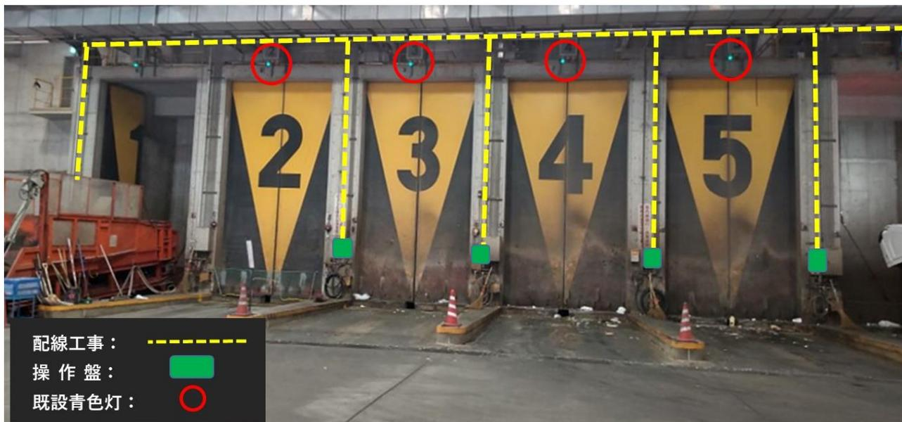
写真－5 ごみ投入扉追加配線施工箇所 1
