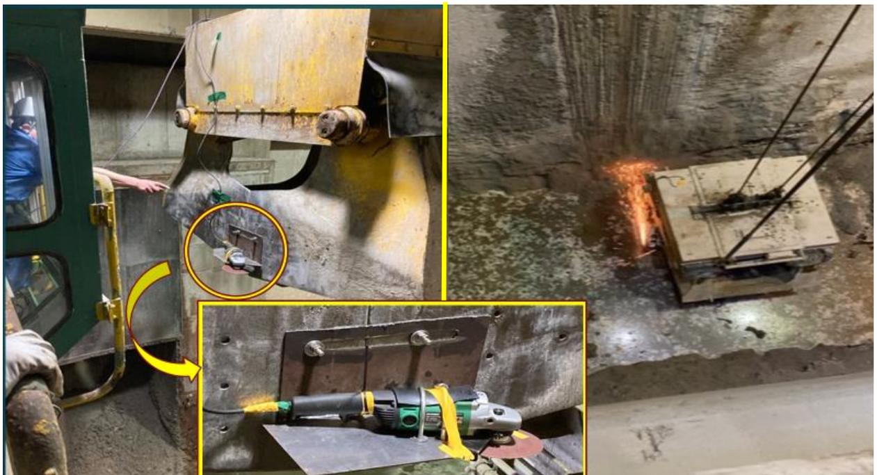
写真-2 バケットへのグラインダ取付状態と鉄筋切断風景
