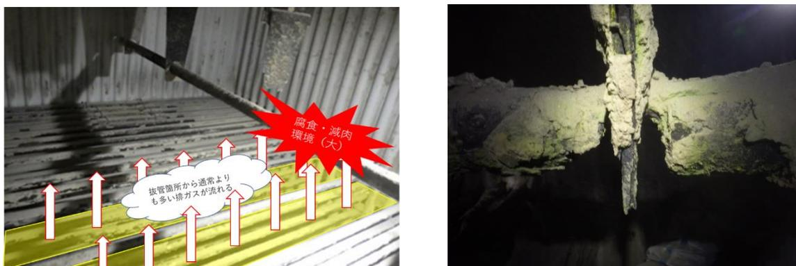
写真－2 推測されるエレメントパイプ破断のメカニズム
