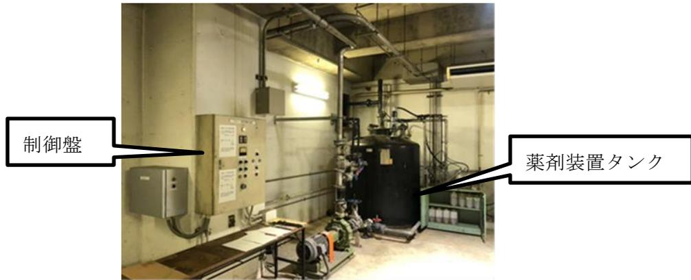
写真－1 ごみピット薬剤噴霧装置制御盤及び薬剤装置タンク
