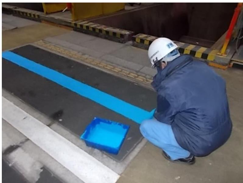
写真－１３ 線引き作業の様子
