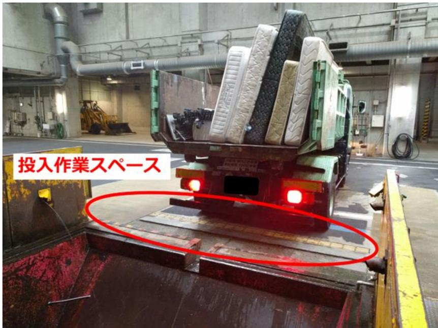
写真－7 投入装置付近の作業スペース
