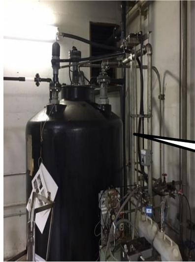
攪拌空気配管と薬剤注入配管
