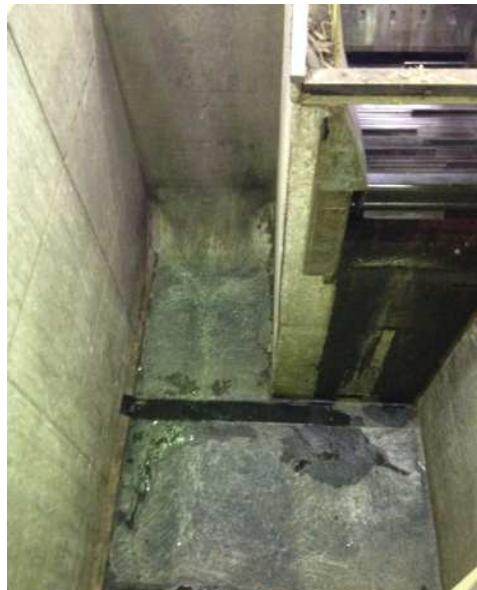
写真 - 6 作業終了後の可燃ピット
