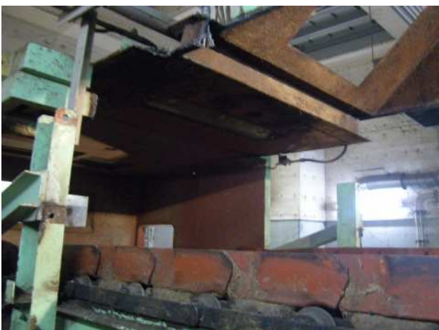
写真 - 6 ケーシング撤去後
