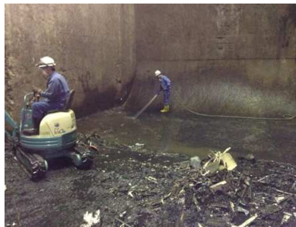
写真 - 4 ショベル使用の不燃ピット清掃作業
