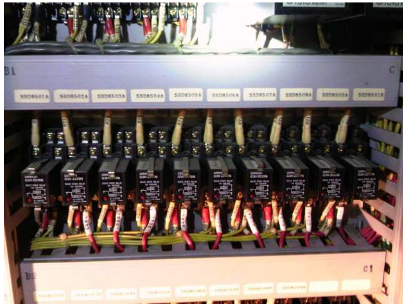
写真 - 12 既設回路への増設回線の接続 ( 2 )【扉番号】
