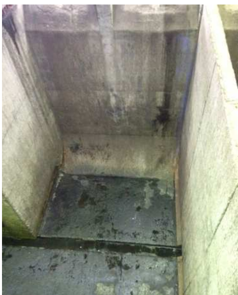
写真 - 5 作業終了後の不燃ピット
