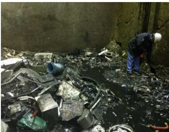
写真 - 2 不燃ピット清掃作業
