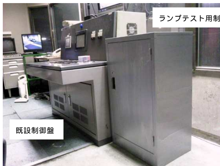
写真 - 9 制御盤の設置
