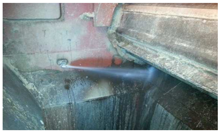
図 - 15 ノズル取り付け後水噴射をしている様子
