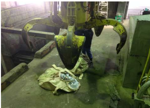
写真 - 1 フレコンバック吊り上げ作業
