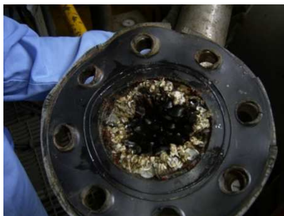
写真 - 6 (配管 清掃前)
