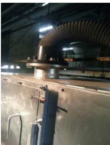
写真 - 9 No.1 コンベヤ先端上部の排気ボックス
