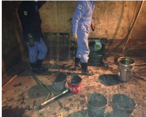
写真 - 7 ごみピット汚水槽清掃作業
