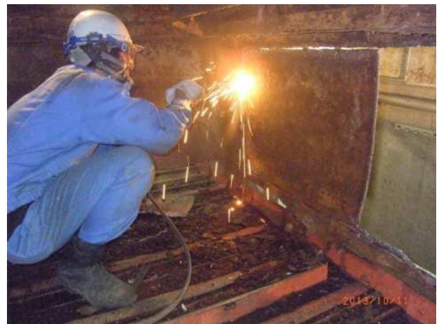
写真 - 5 解体作業の様子
