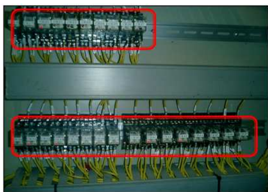
写真 - 6 施工後の制御回路
