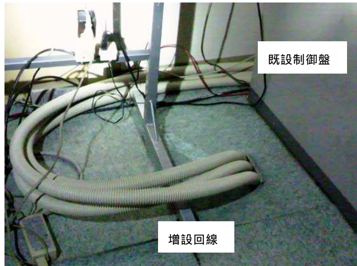
写真 - 10 既設制御盤への増設回線の入線
