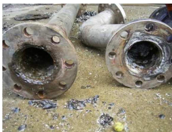
写真 - 8 (配管 清掃後)
