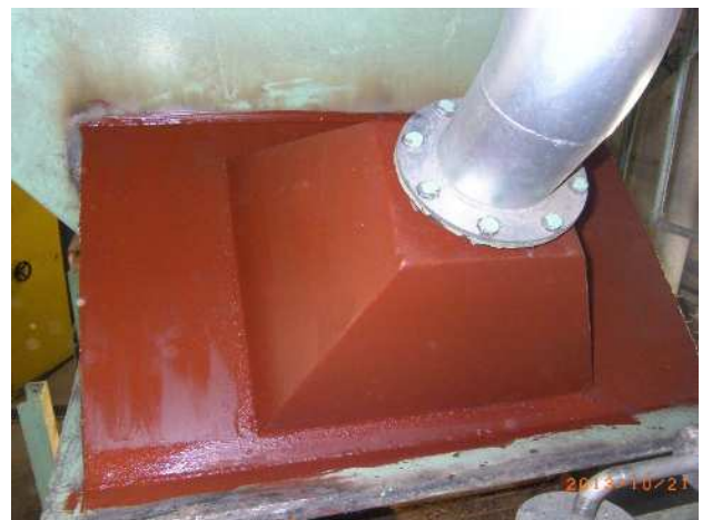
写真 - 11 ケーシング側面取り付けの様子
