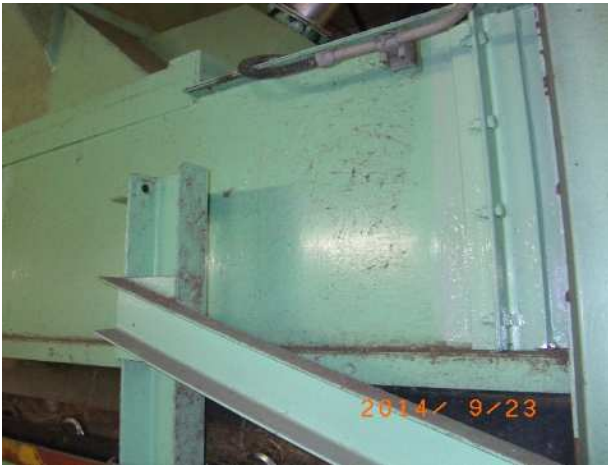
写真 - 8 ケーシング完成後の様子
