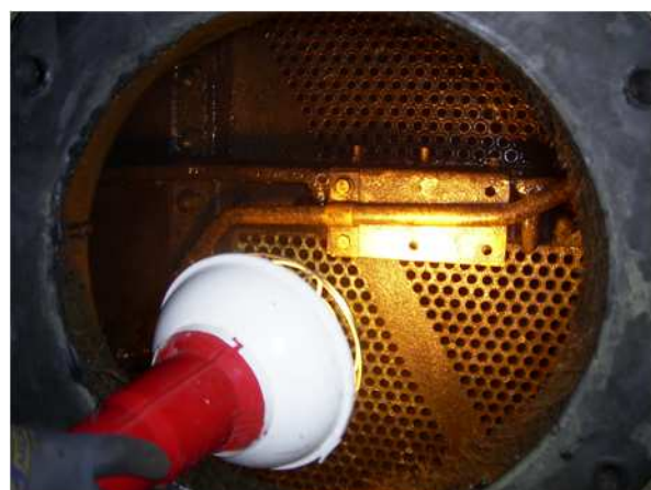
写真 - 7 (復水器内部 清掃後)
