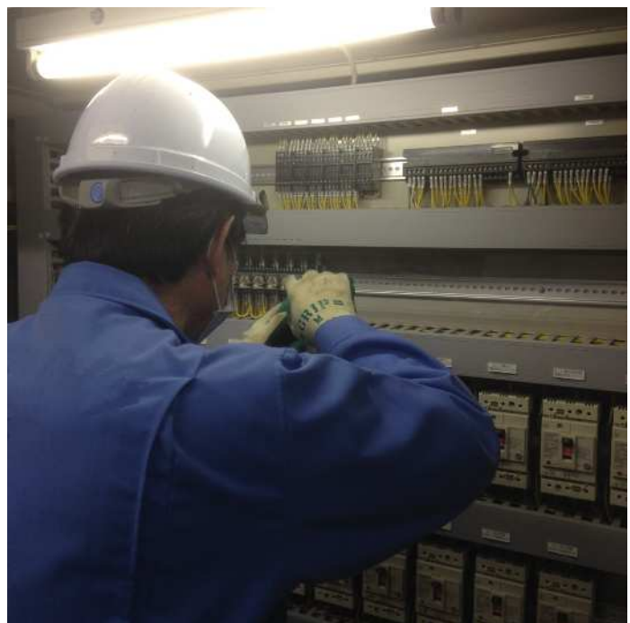
写真 - 2 動力盤での作業の様子
