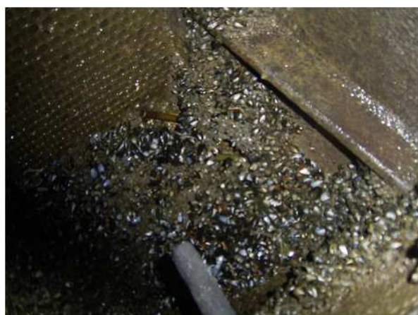
写真 - 5 (復水器内部 清掃前)
